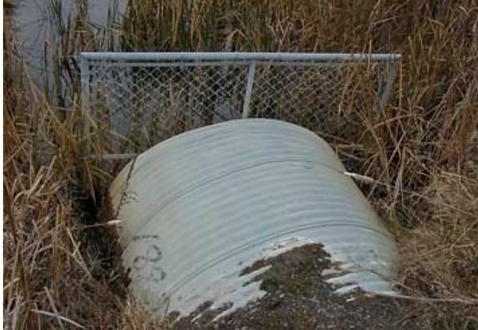
Rys. 9 W rejonach występowania bobrów, wszystkie przepusty pod drogami powinny być zabezpieczone (Droga 417, Ottawa – Montreal). Całkowite przysłonięcie przepustu siatką zmusza jednak bobry do przejścia drogi. Przy tym przejściu w 2002 roku zginęły pod kołami samochodów dwa młode bobry.
