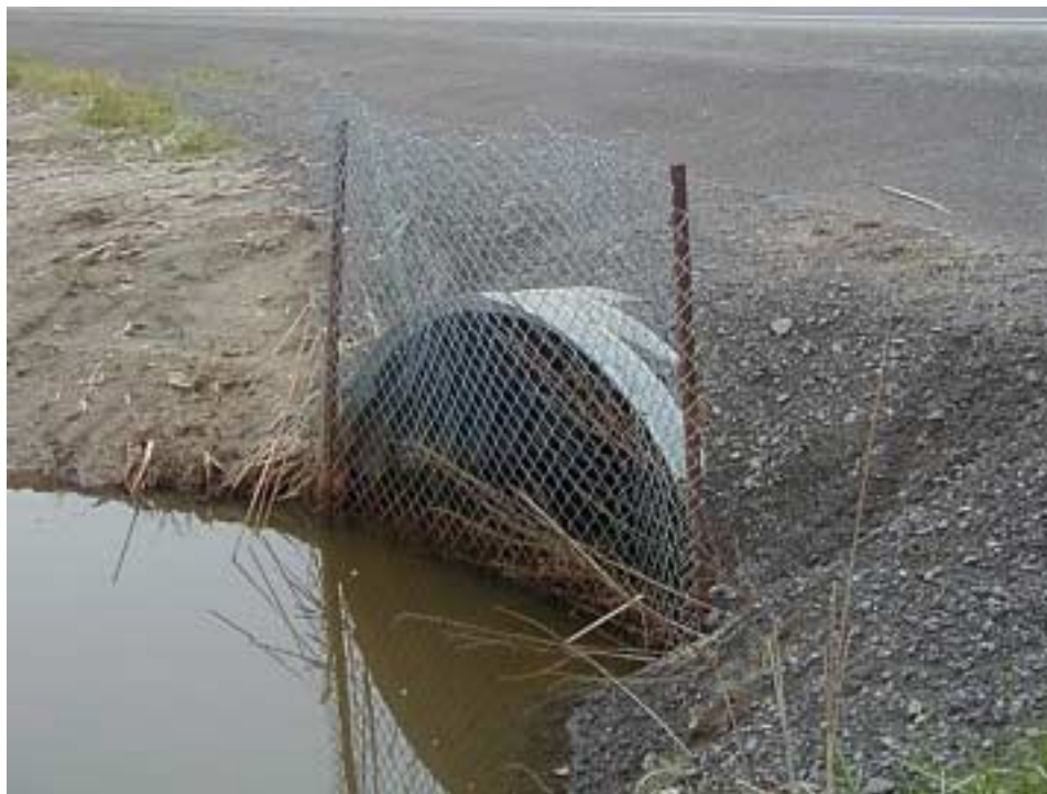
Rys. 7 Prowizoryczne zabezpieczenie przepustu pod nowo wybudowanym zjazdem z autostrady.
